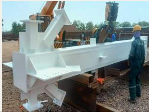
Weld Edge Preparation
